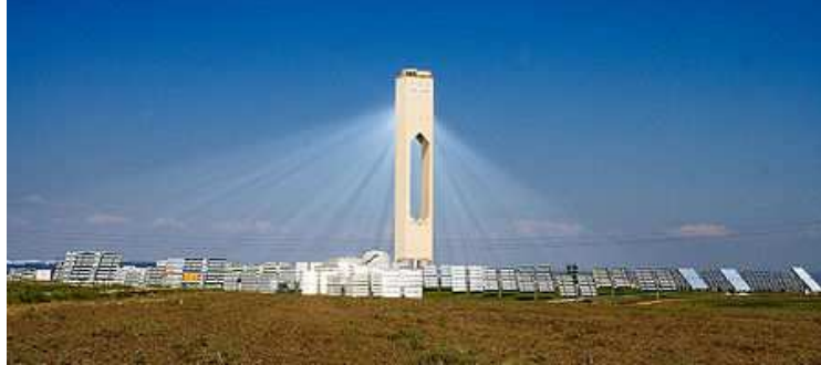
Figura 20: Torre solar (Abengoa Solar, 2010).
