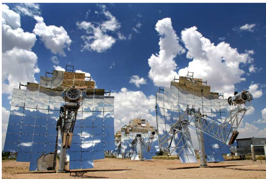
Figura 19: Concentradores solares do tipo "dish" (Sandia National Laboratories, 2008).
